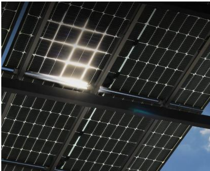
Afbeelding 2.9: beeldvorming van lichtdoorval tussen zonnecellen van bifacial zonnepaneel
