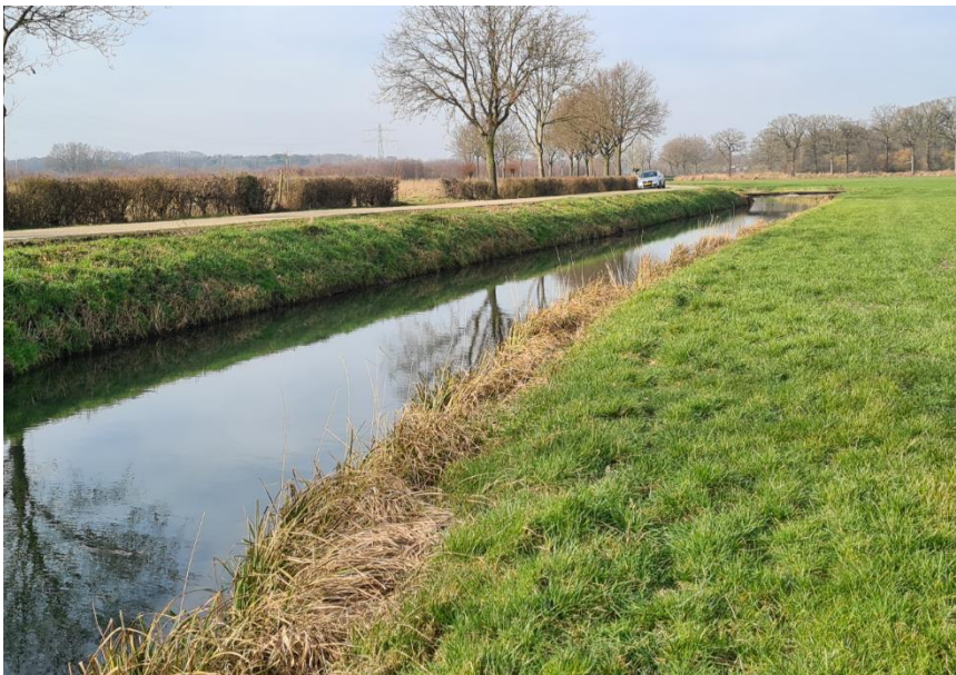
Figuur 5: Overzicht sloot vanuit noordoostelijke hoek
