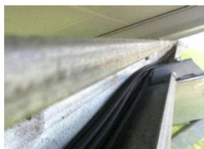
Afbeelding 14: De DC-bekabeling wordt veilig in een kabelgoot onder de panelen weggeborgen.
