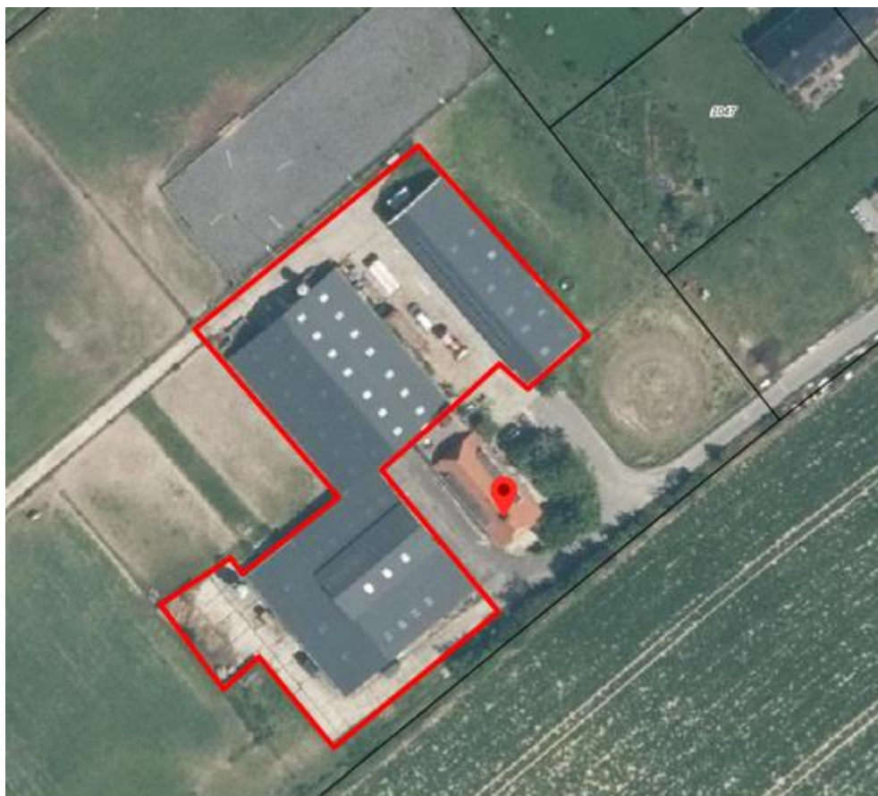
te slopen bebouwing (gebouwen, erfverharding), circa 3.500 m 2
