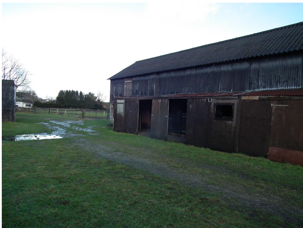
Figuur 2 De ontwikkeling betreft het slopen van een deel van de opstallen ten behoeve van een tweede woning met bijgebouw en de aanleg van siertuin.
