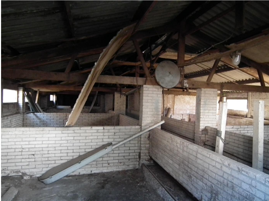
Figuur 3 Vrijwel alle te slopen opstallen zijn opgetrokken uit betonnen of golfplaten wanden en muren met golfplaten daken en een houten constructie. Enkel bij de stallen zijn aan de binnenzijde gemetselde muren aanwezig.
