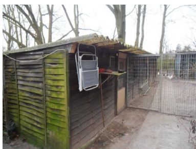
Bebouwing no. 23 t/m 26
