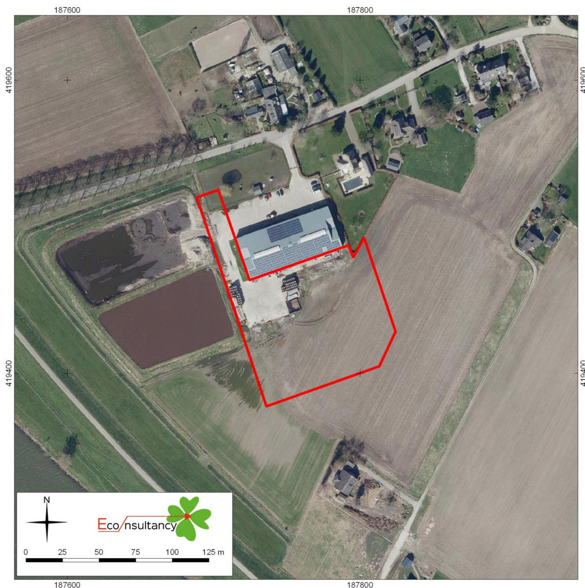
Figuur 3. Het plangebied op een luchtfoto
