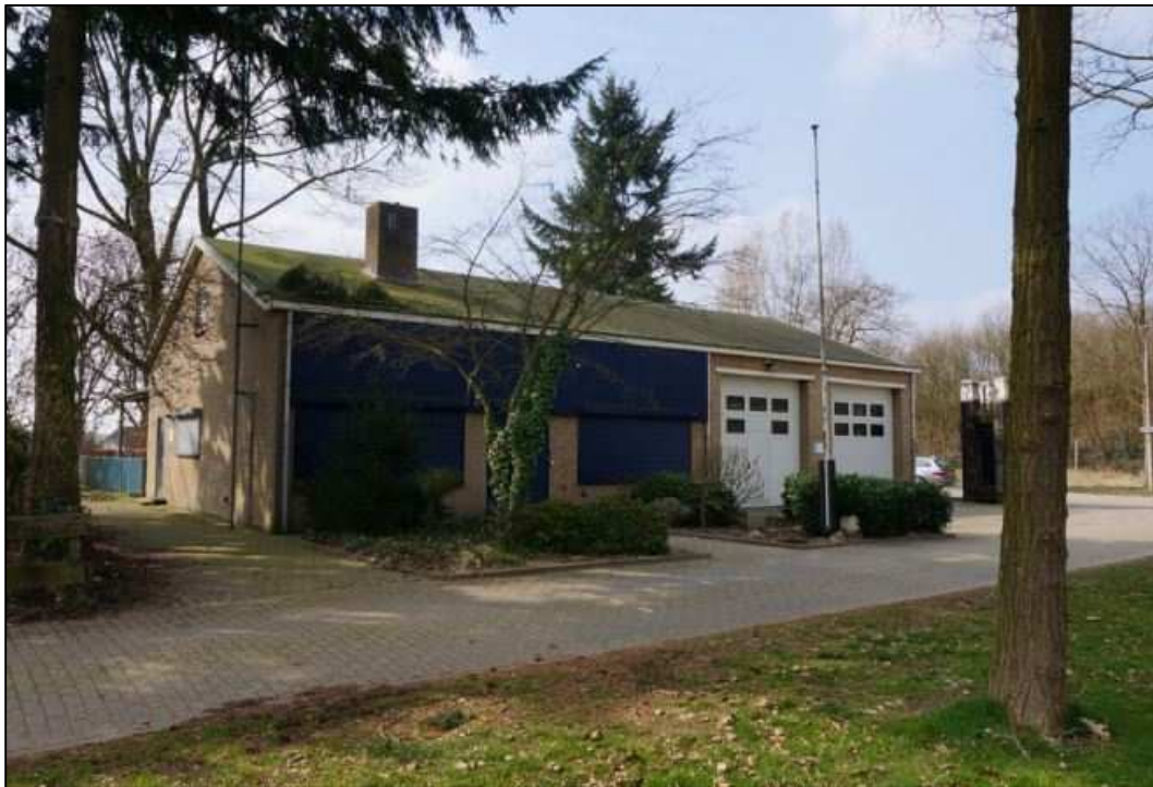
Bestaande bebouwing (voorgevel)
