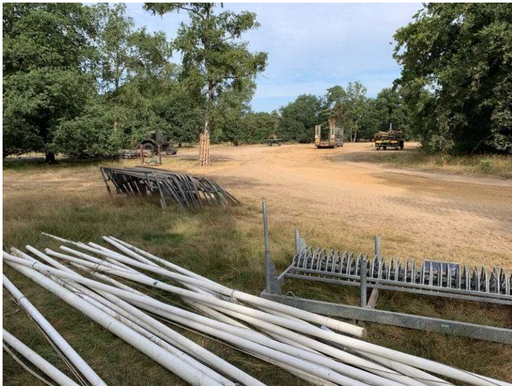
Foto 3 Opruimwerkzaamheden in het noordwestelijk deel van het Vierdaagse terrein.
