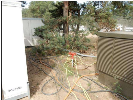
Figuur 18. Territorium van een zandhagedis nabij een trafo-gebouwtje.
