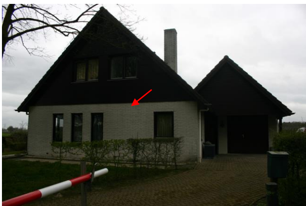
Figuur 6.3. De woning waarin de vleermuisverblijven zullen worden gerealiseerd. Een geschikte locatie om de open stootvoegen te maken is met een rode pijl weergegeven (op enige afstand van ramen).
