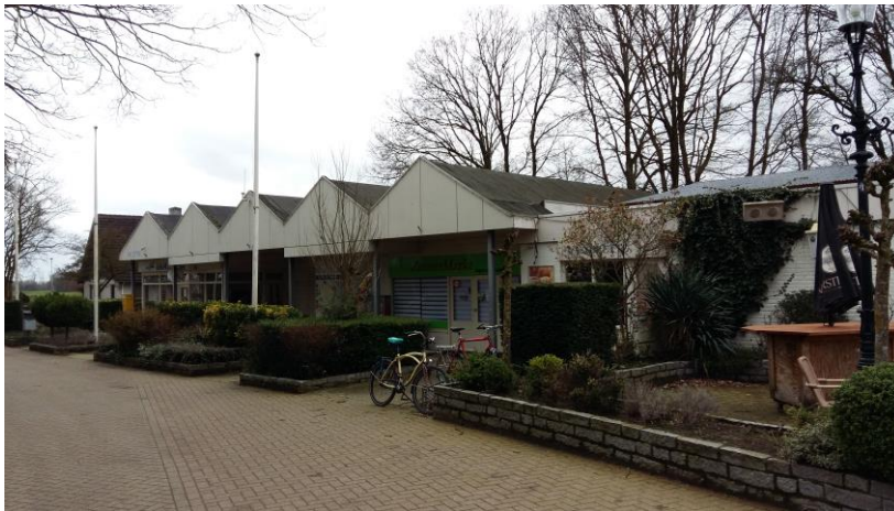
Centrale voorzieningen Heumens Bos
