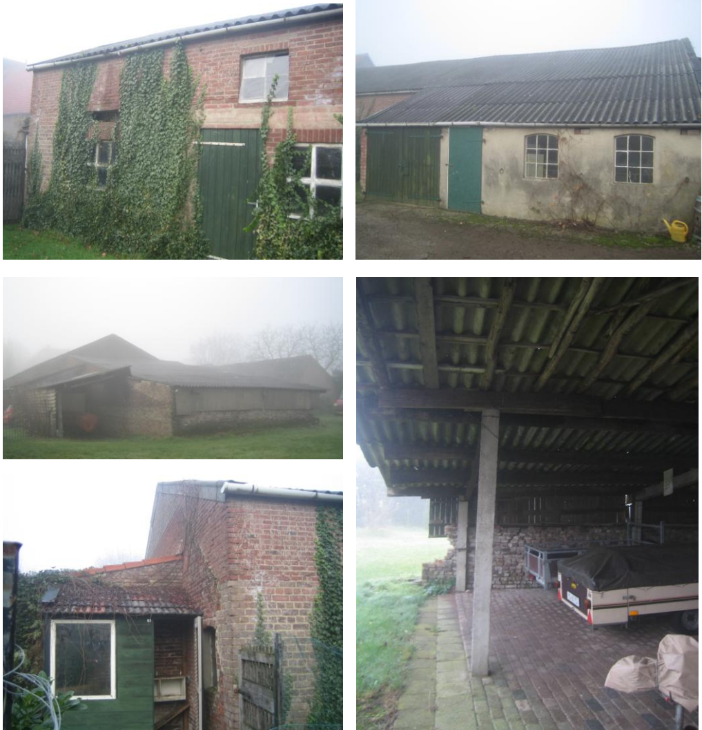
Afbeelding 2: Impressie te slopen gebouwen in het plangebied (Foto's: SAB, 2010)
