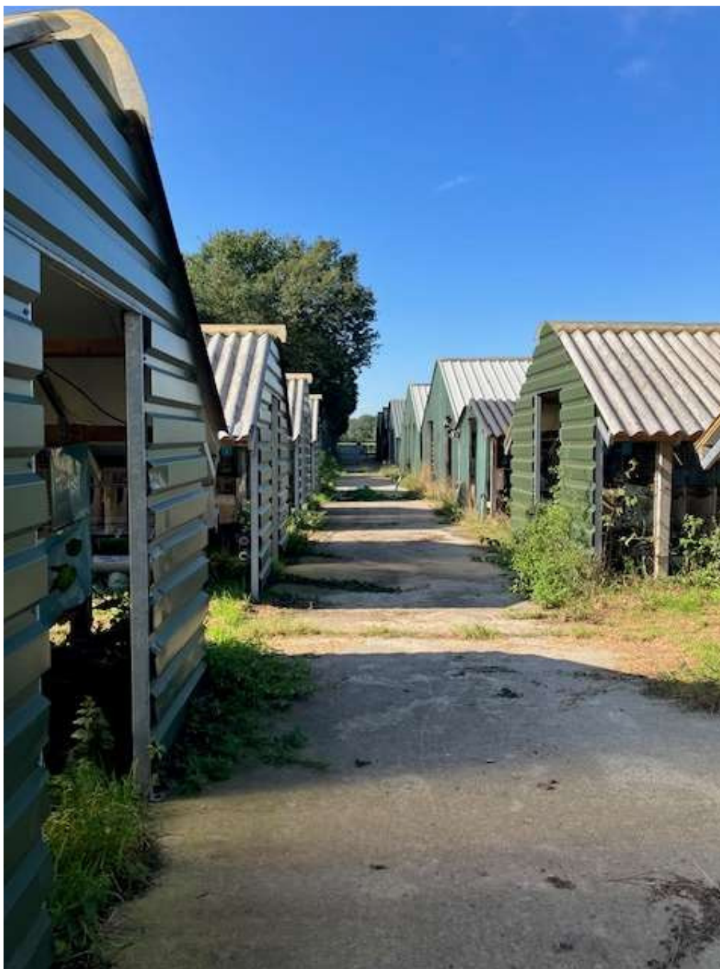
• Afbeelding 4: Erfverharding tussen de sheds, deze worden gesloopt
