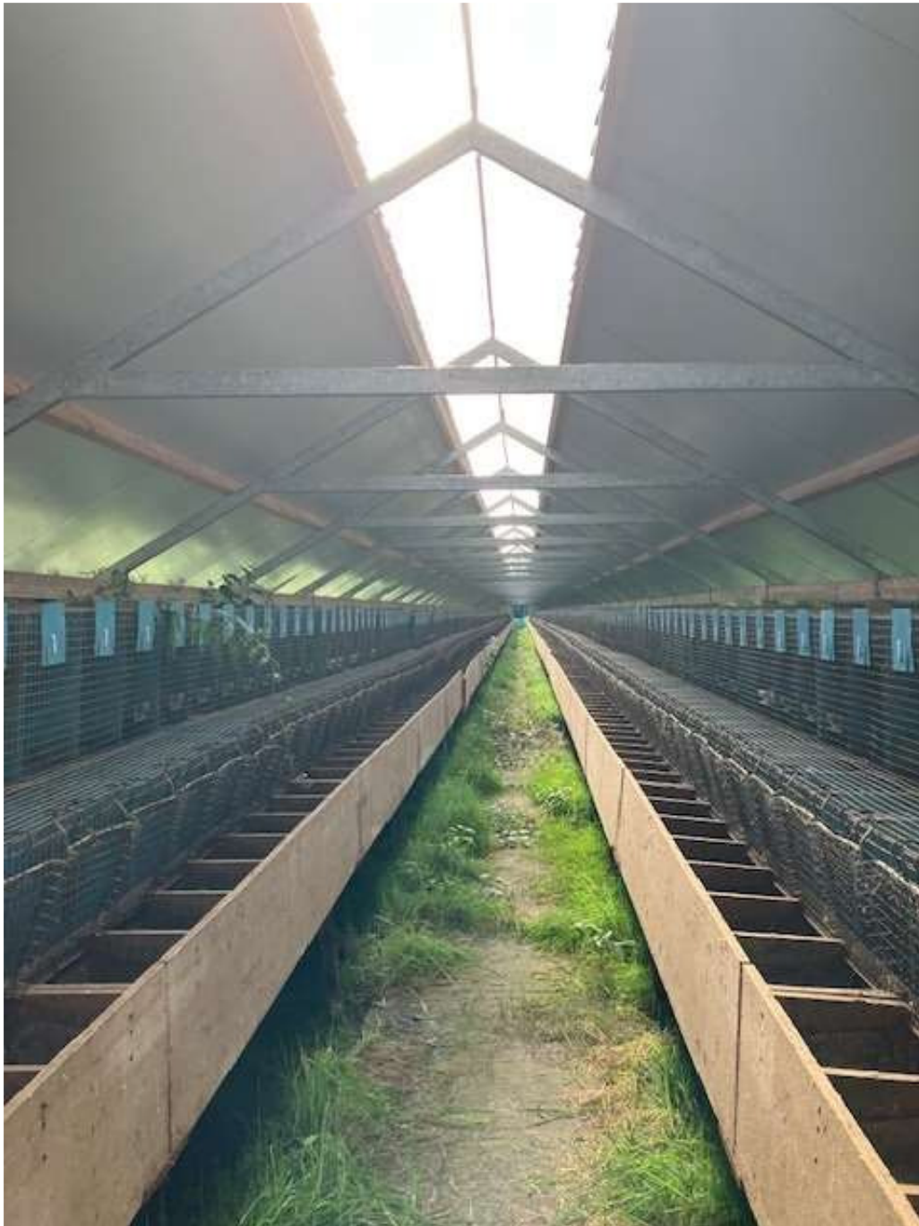
• Afbeelding 9: Binnenzijde sheds, worden gesloopt
