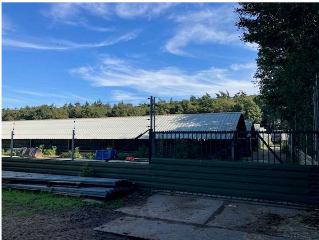
• Afbeelding 19: Omheiding van het terrein gemaakt van damwand met daarboven schrikdraad, op de achtergrond de te slopen sheds
