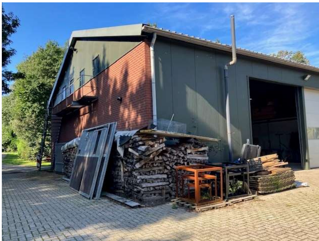
• Afbeelding 8: Schuur, blijft behouden
