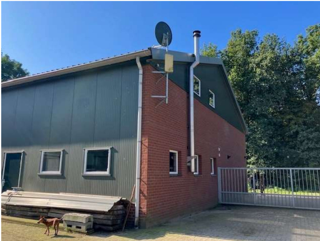
• Afbeelding 5: Schuur blijft behouden
