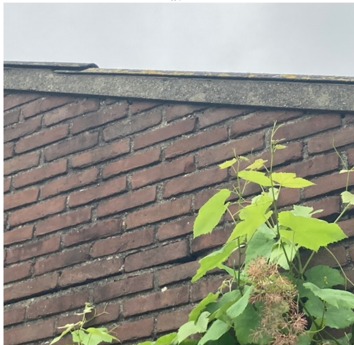
Deel van opening in de muur. De donkere substantie is kurk in poedervorm. Hiermee zijn alle muren geïsoleerd. Het poeder maakt het voor vleermuizen onmogelijk om gebruik te maken van de muren als vaste rust- of verblijfplaats.
