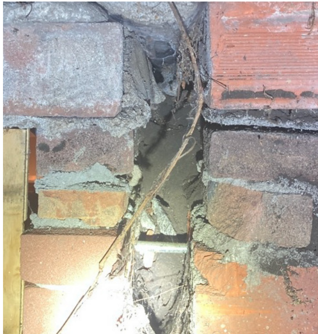
Deel van opening in de muur. De donkere substantie is kurk in poedervorm. Hiermee zijn alle muren geïsoleerd. Het poeder maakt het voor vleermuizen onmogelijk om gebruik te maken van de muren als vaste rust- of verblijfplaats.
