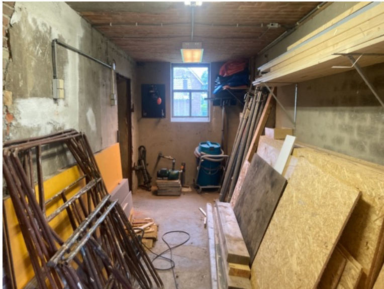
Ander deel van het gebouw dat in gebruik is als schuur/opslag.
