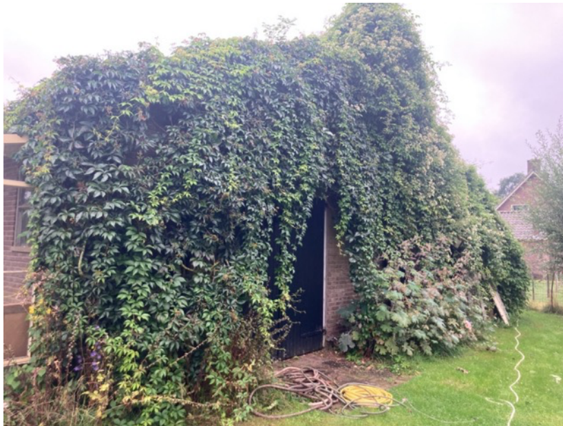
Voorgevel van het gebouw in het plangebied. De gevel is in zijn geheel ontoegankelijk voor vleermuizen. Mogelijk dat hier wel algemeen voorkomende vogels gaan broeden.
