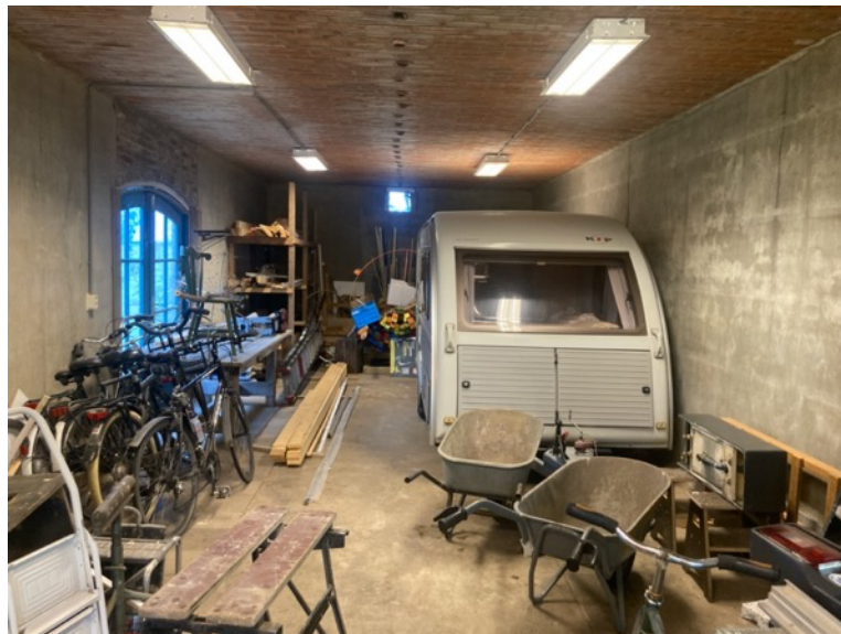
Binnenzijde van het gebouw. Ten tijde van het veldbezoek was het gebouw in gebruik als schuur/opslag. In het plafond zijn de openingen te zien die een functie hadden bij het transport van warmte tijdens het kweken van champignons.
