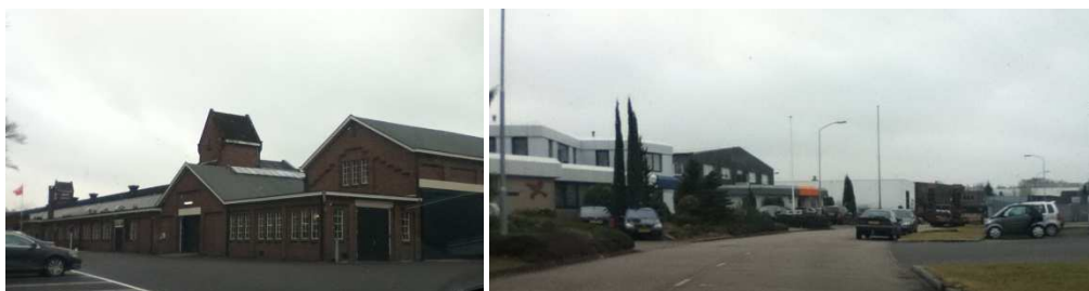
Afbeelding 2.4 Oudere en nieuwere bebouwing op het bedrijventerrein
