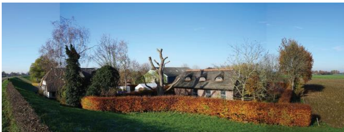
Foto bestaande situatie met bestaande volbladhaag om het perceel
