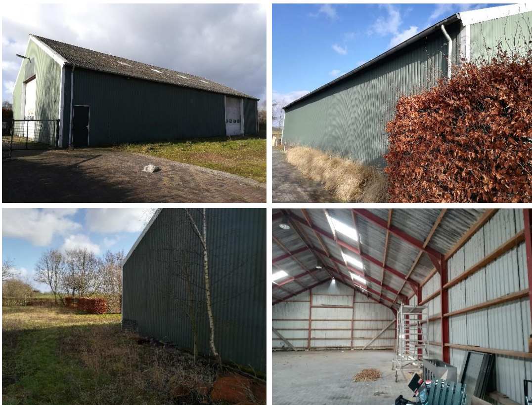
Indrukken van het plangebied, van links tot rechts en van boven naar beneden: zuid- en oostaan­zicht van de loods, westaan­zicht van de loods met haagbeuk op de voorgrond, noordaan­zicht van de loods en binnenkant van de loods (foto's: Laneco).
