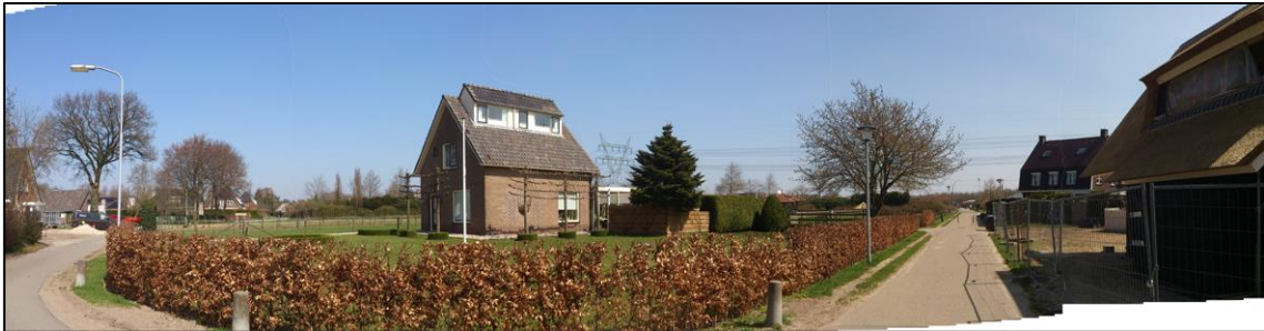
Afbeelding 5: Bestaande woning Grensweg 11 vanaf de hoek Grensweg - voormalige Elsweg.
