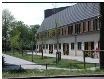
Waterinfiltratiestroken in het nieuwe Stadsdennen-Oost.
