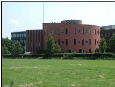
Kantoorpark aan het Oosteinde.
