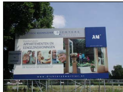
Nieuwbouw op het Californiaterrein: het nieuwe Dichterskwartier.
