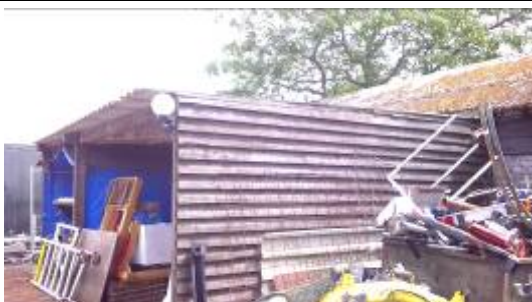
Kapschuur van hout met stalen damwandplaten op het dak.
