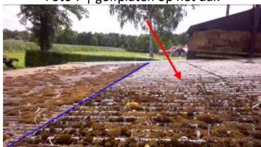
Foto 9 | golfplaten op het dak
