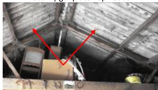
Foto 6 | golfplaten op het dak
