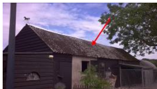
Foto 2 | golfplaten op het dak
