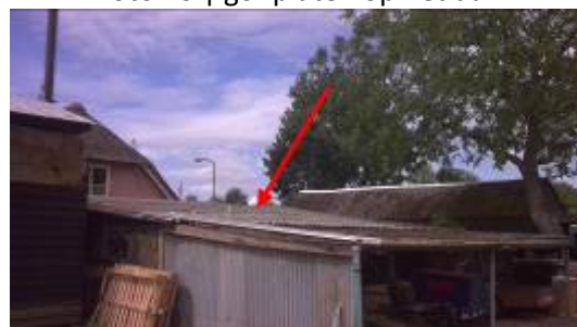
Foto 12 | golfplaten op het dak
