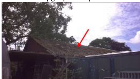
Foto 5 | golfplaten op het dak
