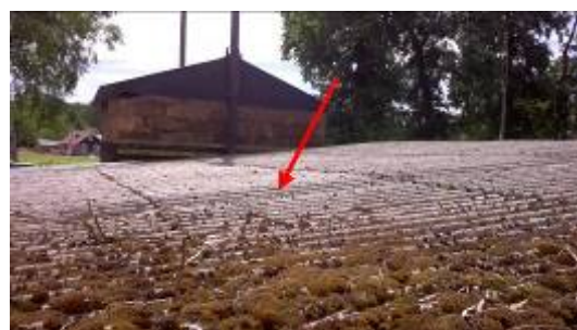
Foto 8 | golfplaten op het dak
