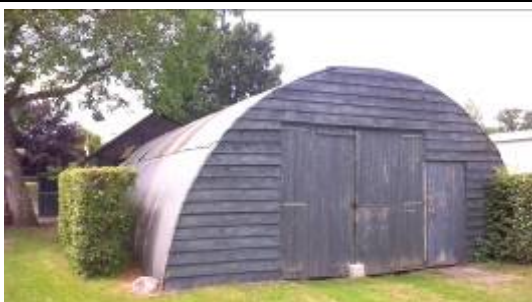
Achterwand van romneyloods is van hout.
