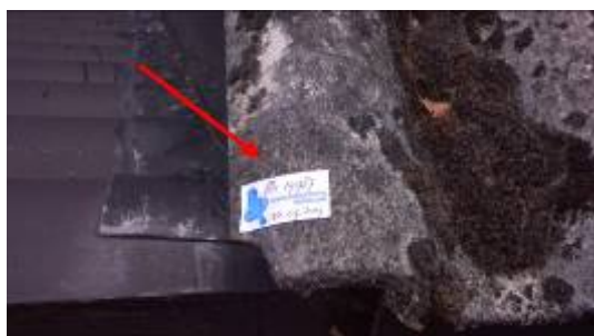
Foto 1 | golfplaten op het dak
