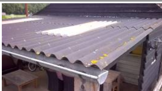
Overkapping terras van hout met asbestvrije golfplaten.
