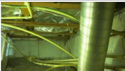
Ruimte boven gipsplaatplafond in kleine woning.
