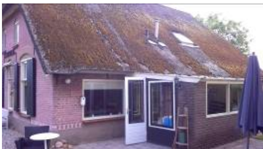
Aanbouw enkel glas in flexibele kit, polyester golfplaten.
