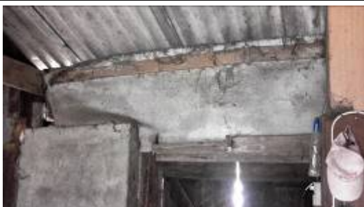
Doek/kleed boven deur in stal is niet asbestverdacht.
