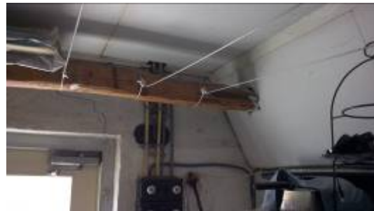
Gipsplaat tegen plafond en schuine kant in bijkeuken.
