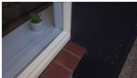
Zijgevel kleine woning, dubbel glas in flexibele kit
