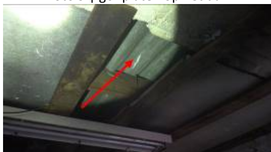
Foto 11 | golfplaten op het dak
