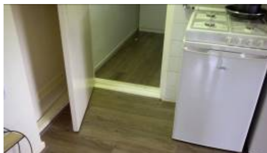
Onder laminaat woonkamer en slaapkamer kleine woning (geen asbestverdachte toepassingen).
