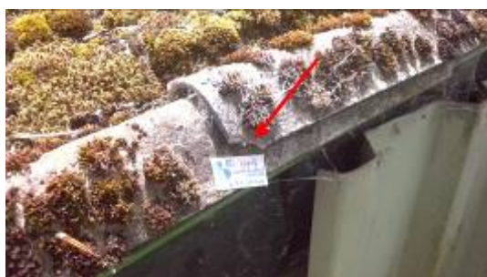
Foto 7 | golfplaten op het dak
