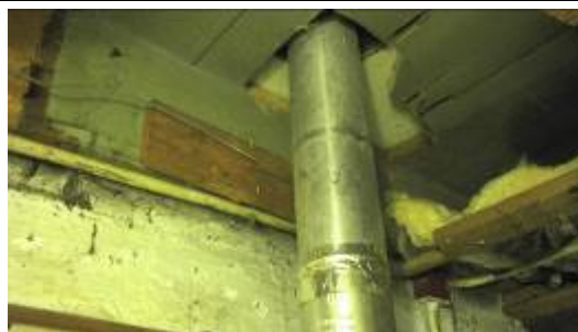
Ruimte boven gipsplaatplafond in kleine woning.
