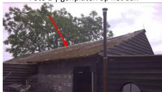
Foto 4 | golfplaten op het dak
