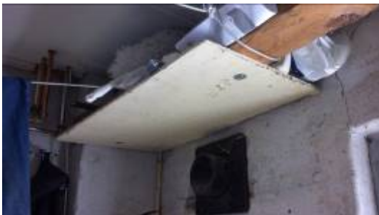
Asbestvrije brandwerende laat tegen balk in bijkeuken.
