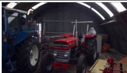
In de romneyloods geen asbestverdachte toepassingen.
