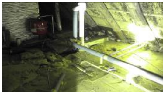
Achter het knieschot is de opbouw van de verdieping zichtbaar, geen asbestverdachte toepassingen.
