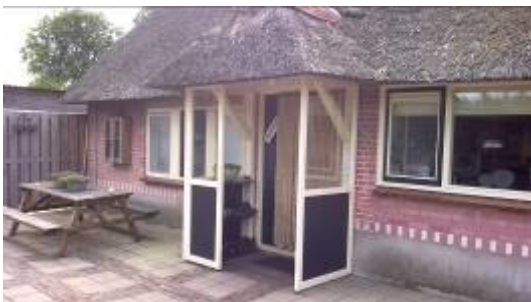
Borstweringspanelen in klompenhok is volkernplaat.
