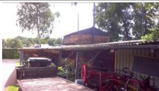
Overkappingen achter de werkplaats, gegalvaniseerde constructie met polyester golfplaten.
