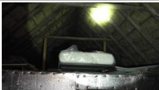
Ruimte boven kamers verdieping.
