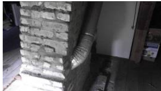
Metalen rookgasafvoer vanuit gemetseld rookkanaal op zolder
