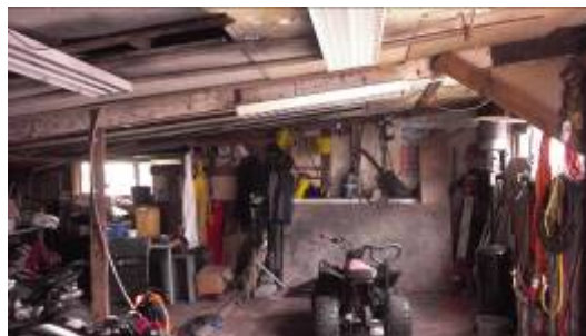
Binnenkant werkplaats, geen asbestverdachte materialen/toepassingen aangetroffen.
