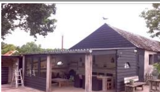
Overkapping terras van hout met asbestvrije golfplaten.
