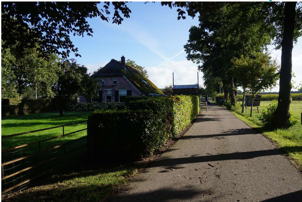
Figuur 2.2. Voorzijde van de woning.
