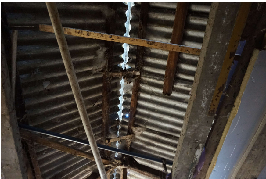
Figuur 5.1. Detailfoto dakconstructie golfplaten.
