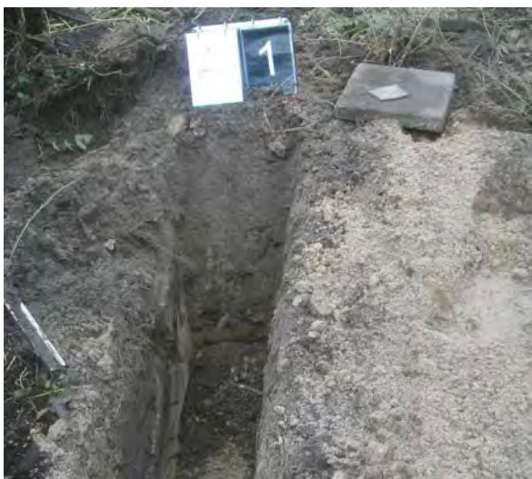
Foto 22: Inspectiesleuf A1 (met aangetroffen asbestverdacht materiaal op tegel)
