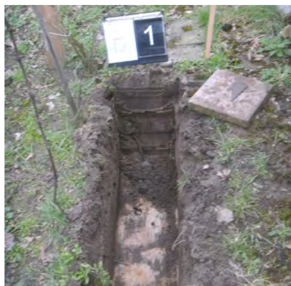
Foto 25: Inspectiesleuf B1 (met aangetroffen asbestverdacht materiaal op tegel)
