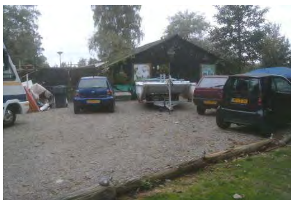
Foto 1: Erf, gesaneerd in 2011 in het kader van Besluit Asbestwegen.
