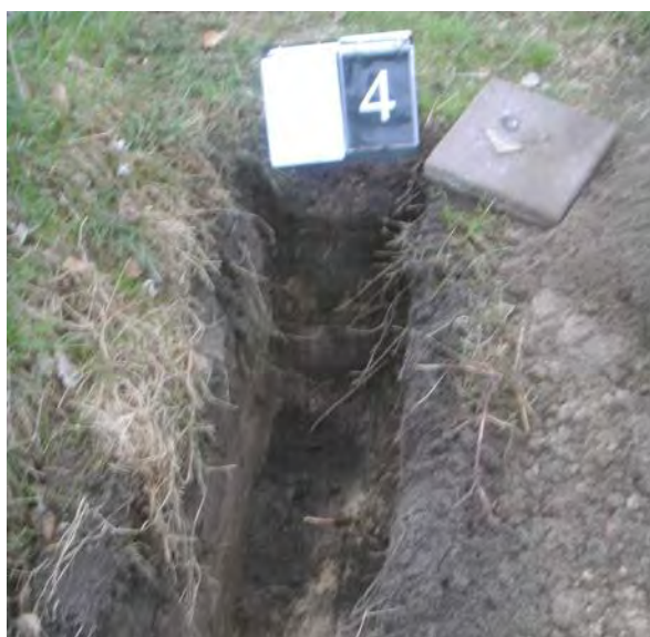
Foto 24: Inspectiesleuf A4 (met aangetroffen asbestverdacht materiaal op tegel)
