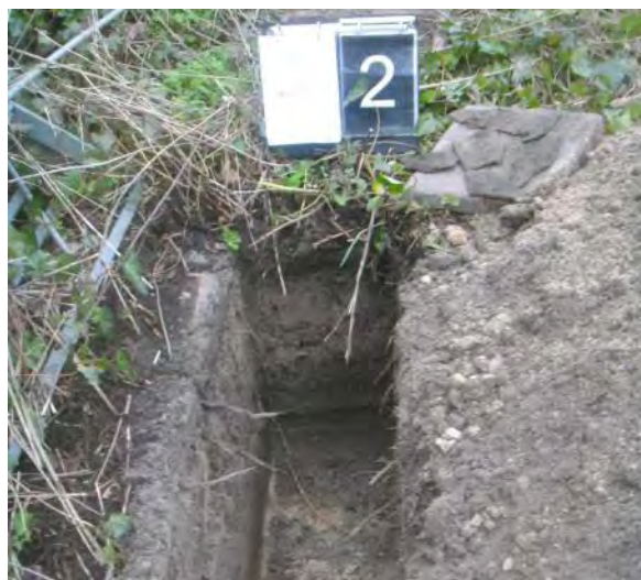
Foto 23: Inspectiesleuf A2 (met aangetroffen asbestverdacht materiaal op tegel)
