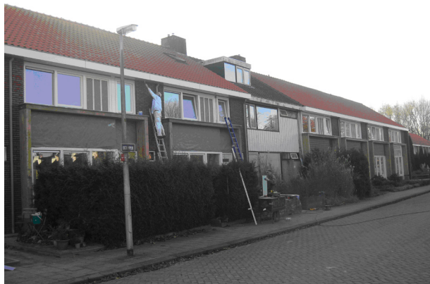
figuur 11 Energiezuinige renovatie in Biddinghuizen
