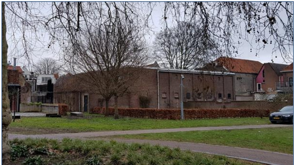
Fig. 2.6: Een weergave van de feitelijke bebouwing in het plangebied met zicht op de zuidzijde van het gebouw, gezien vanuit het Hortuspark.
