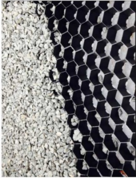
Uitvoering van het binnenpad met grind in grindmatten. Naast een prettig beeld draagt dit bij aan een goede infiltratie van het hemelwater.
