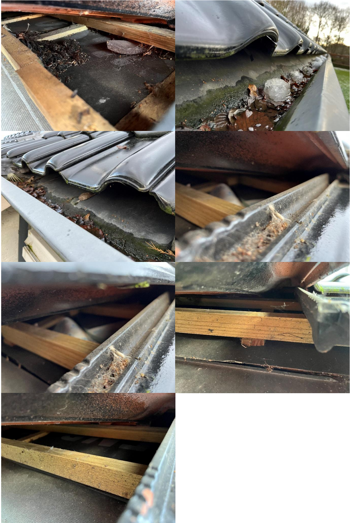
Foto's van de onderste rij dakpannen en de ruimte eronder.
