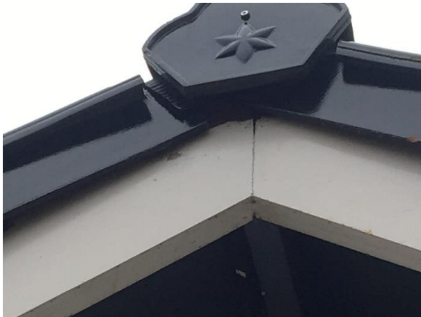
De gevelpannen en nokvorst sluiten strak aan.
