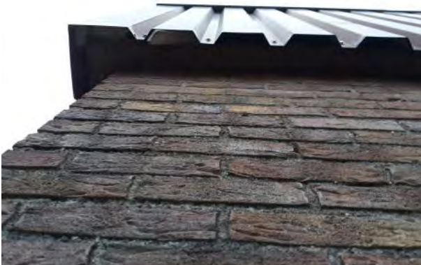
Ruimte onder damwandprofielen loods A.
