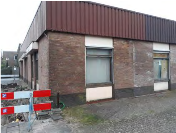
Zijkant loods A met damwandprofielen
