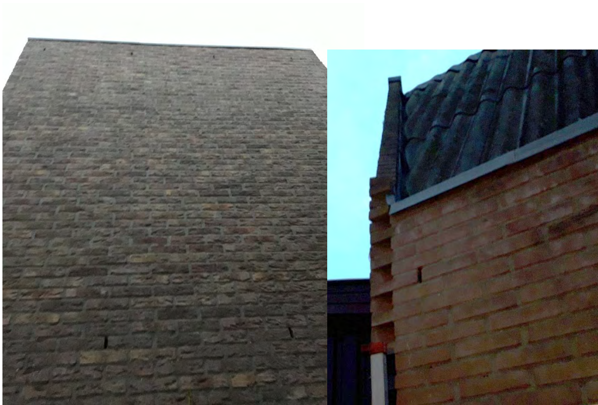
Afbeelding 2: Open stootvoegen die toegang tot de spouwmuur bieden (foto: Laneco)
