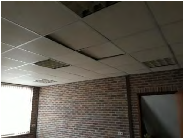
Kantoorruimte met verlaagd plafond
