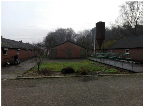
1: Vee stallen op locatie (buiten gebruik)
