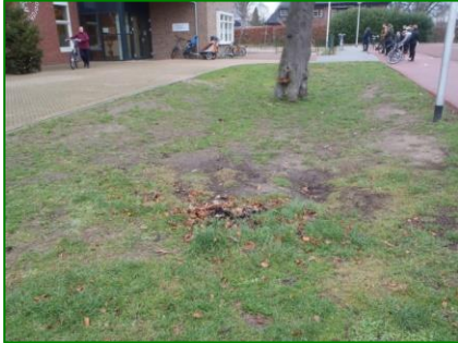
Foto: de bestrating van een 8 jaar geleden aangelegd schoolplein, waterde af op de groeiplaats van drie beuken. Door de vernatting zijn wortels afgestorven. Reuzenzwam heeft omvangrijke wortelrot veroorzaakt waardoor de bomen windworp gevaarlijk zijn geworden. De laatste beuk die op deze foto te zien is, is ook vanuit veiligheidsoverwegingen geveld.
