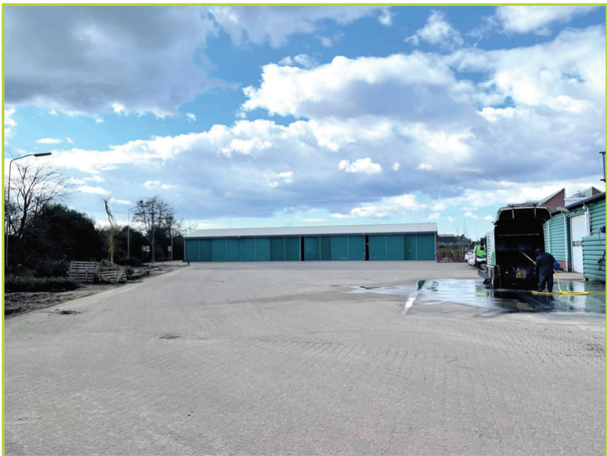
Afbeelding 3: Een van de eigenschappen van het plangebied is dat ongeveer 80% van het plangebied verhard is. Meer foto's zijn te zien in de fotobijlage (Bijlage 1).
