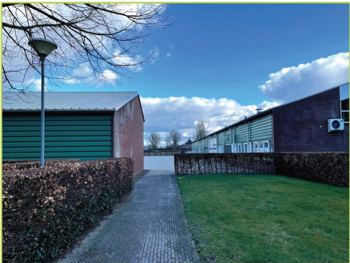
Afbeelding 6: Opstallen met platen als dak, geen dakpannen, geen open stootvoegen.
