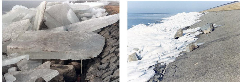
Figuur 23 Links een foto van flinke ijsschotsen tot de berm van een dijk. Rechts kruiend ijs op de houtribdijk. Merk op dat de steenbekleding los is gekomen door het ijs.
