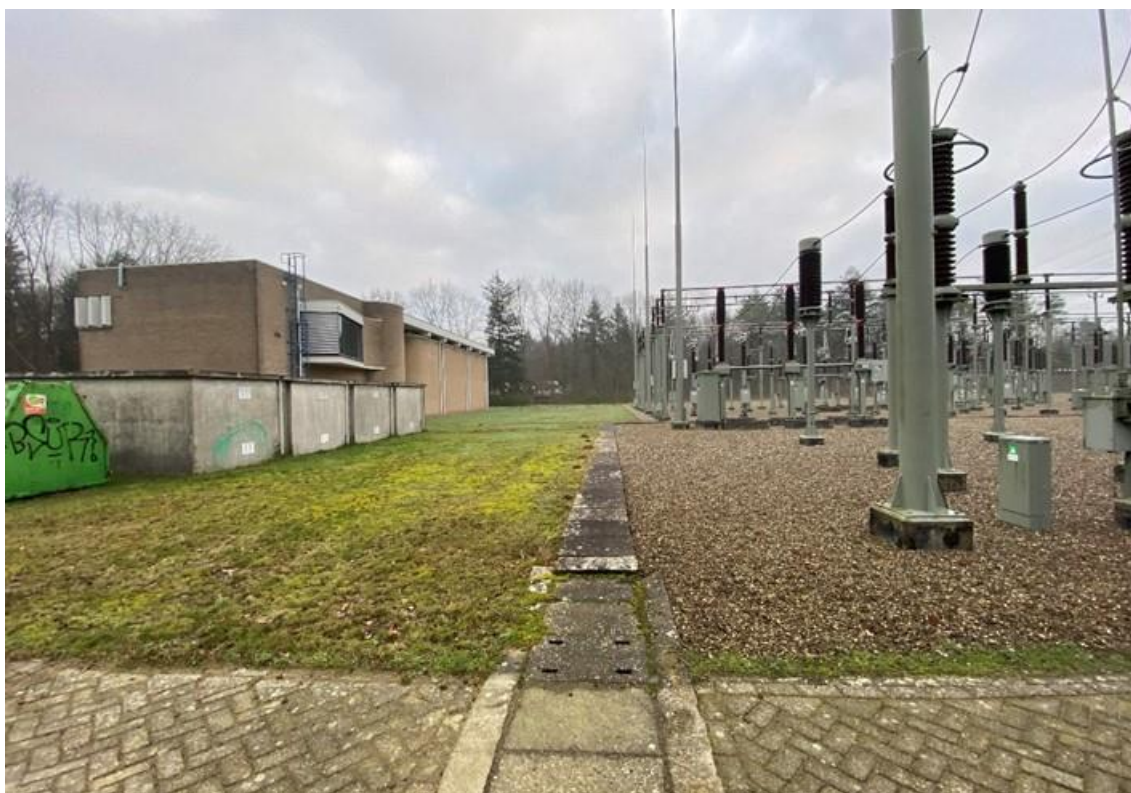
afbeelding 4: impressie van de bestaande situatie (bron: Qirion)
