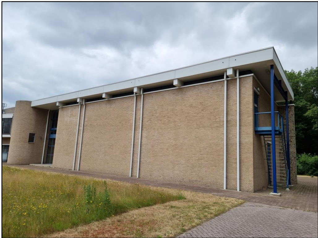
Figuur 4 De kantoren / opslag op het terrein van het transformatorstation.
