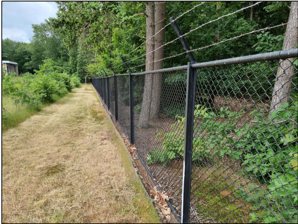
Figuur 3 De planlocatie is volledig omheind door harmonicahekwerk dat ook ingegraven is.
