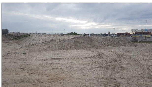
Afbeelding 1.6 | Aan de westzijde van het terrein is een grondepot aanwezig.
