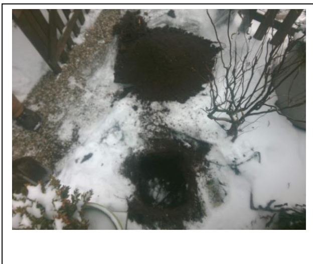
Foto: Inspectiegat A26
