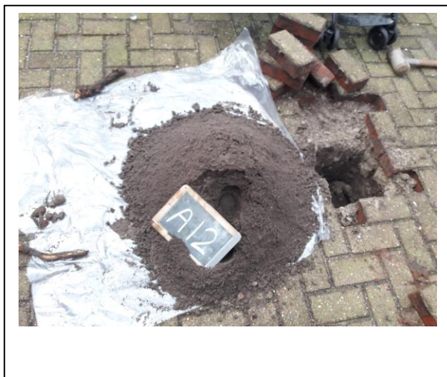
Foto: Inspectiegat A12
