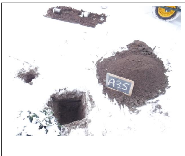
Foto: Inspectiegat A35
