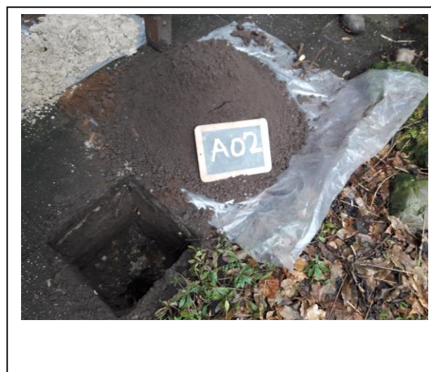
Foto: Inspectiegat A02
