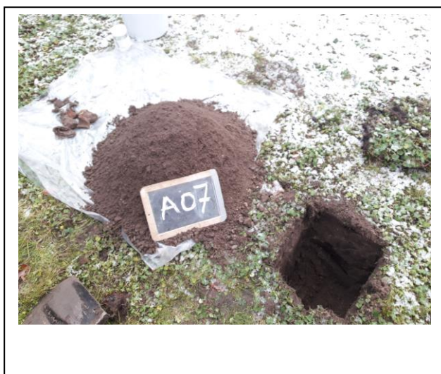
Foto: Inspectiegat A07
