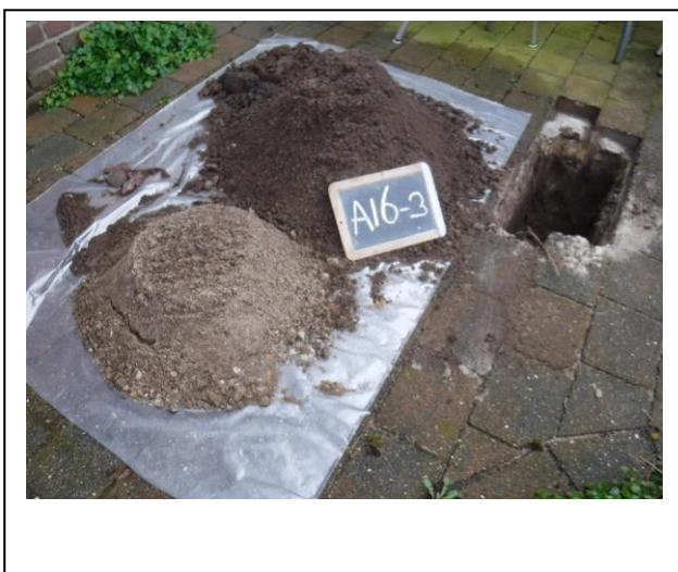
Foto: Inspectiegat A16-3
