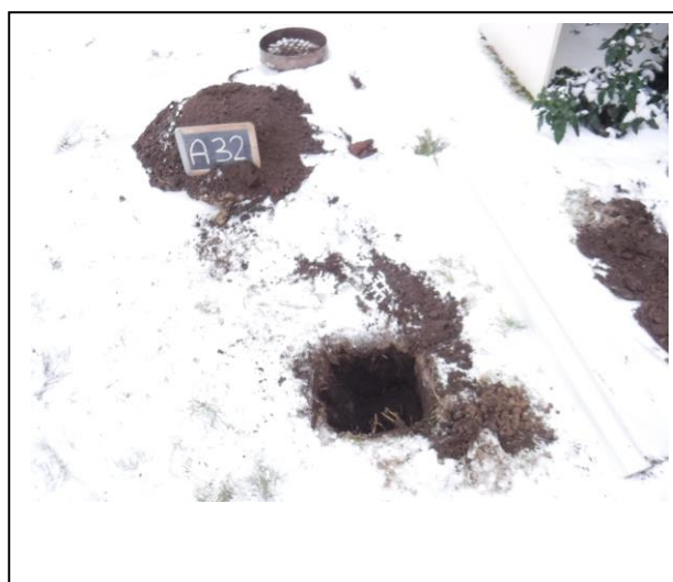
Foto: Inspectiegat A32
