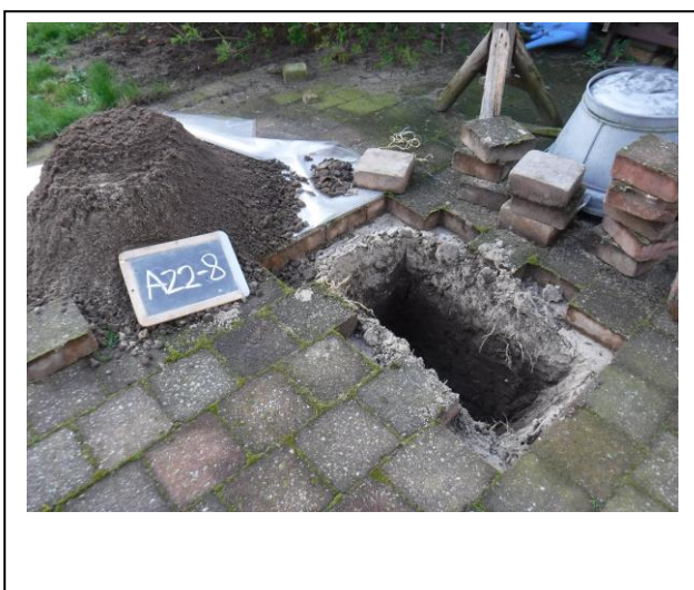
Foto: Inspectiegat A22-8
