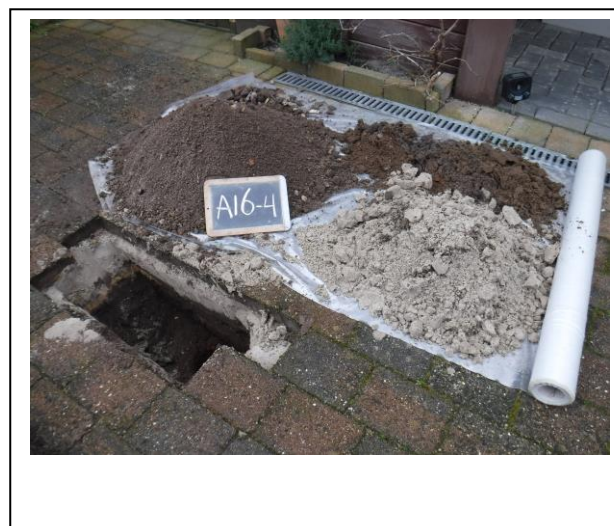
Foto: Inspectiegat A16-4
