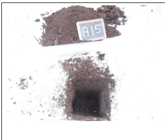
Foto: Inspectiegat A15
