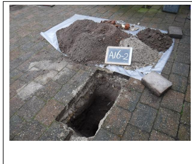
Foto: Inspectiegat A16-2
