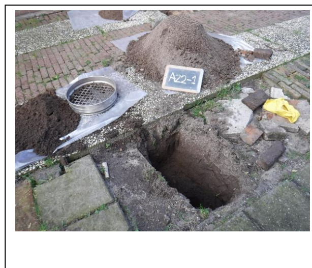
Foto: Inspectiegat A22-1
