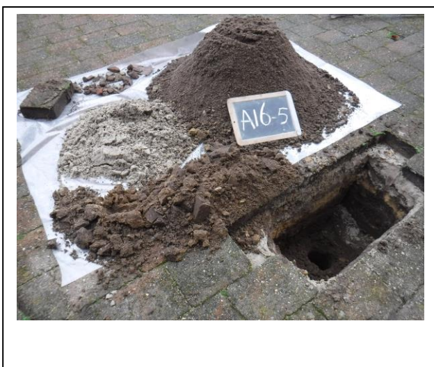
Foto: Inspectiegat A16-5
