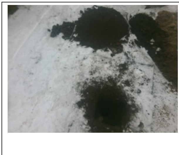
Foto: Inspectiegat A22
