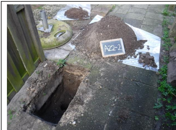
Foto: Inspectiegat A22-2
