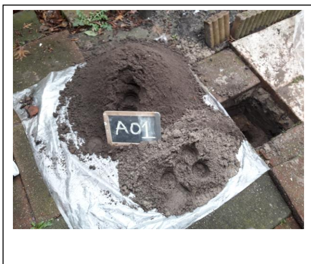
Foto: Inspectiegat A01
