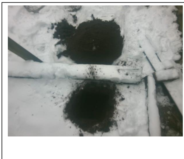
Foto: Inspectiegat A24
