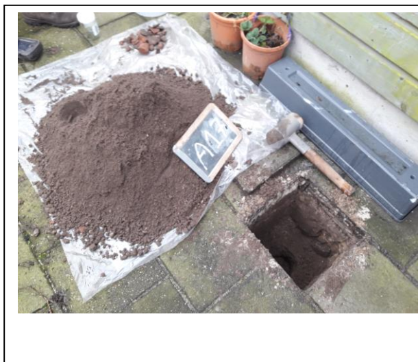
Foto: Inspectiegat A17
