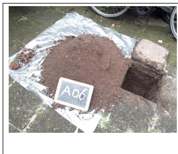
Foto: Inspectiegat A06
