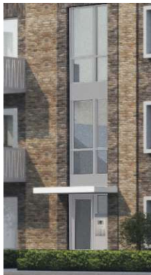
Portaal entree & trappenhuis
