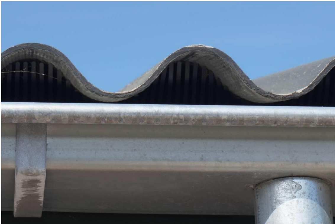
Figuur 5.2. Afwerking dak met vogelschroten.
