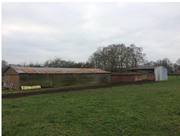
De bovenbouw van vier schuren aan de Glindweg 8 te Hierden
