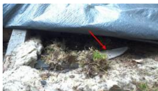
Foto 25 | restanten asbestcement
