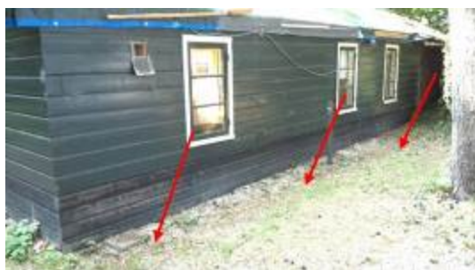
Foto 20 | restanten asbestcement
