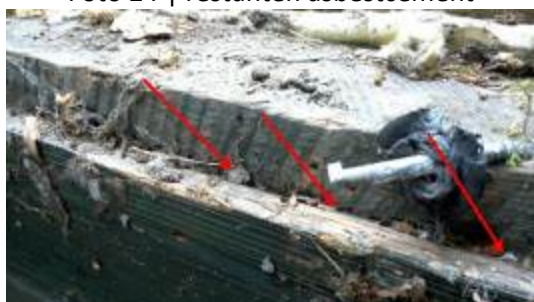
Foto 26 | restanten asbestcement
