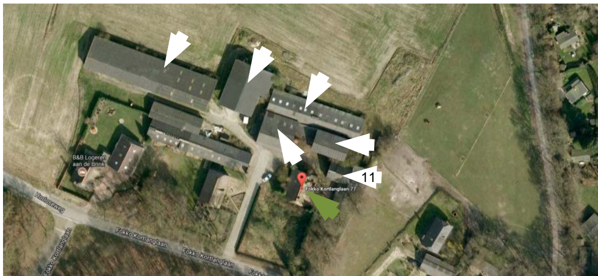
Luchtfoto 1: Situatie vóór de sloop. Gesloopte panden met pijl aangegeven (bedrijfsgebouwen in wit, woning in groen).
