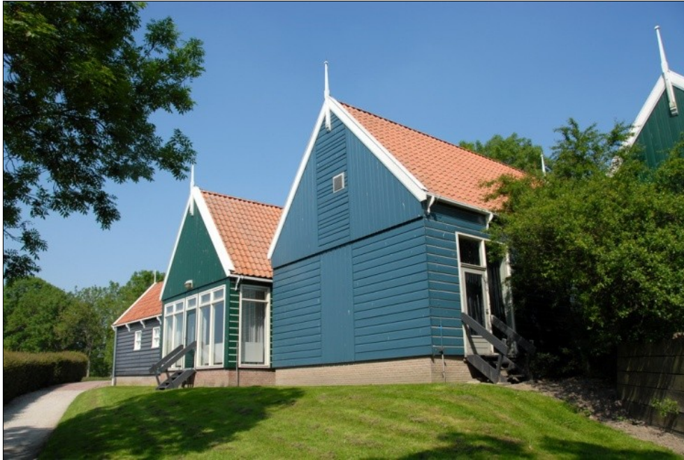
museum Schokland: niet-traditionele patronen in de gevelbetimmering
