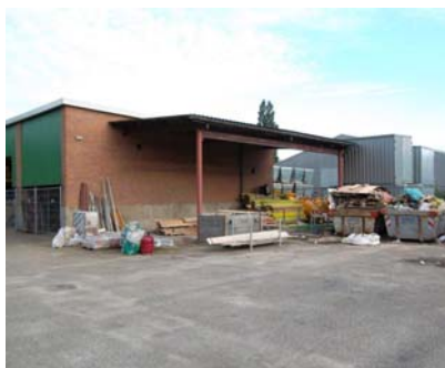
Foto 3: Achterzijde loods, locatie voormalige diesel- en benzinetanks met pomp (deellocatie B en E)
