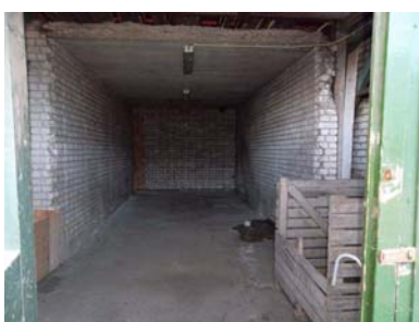
Foto 7: Voormalige olieopslag en ligging ondergrondse benzinetank in houtloods (deellocatie F)
