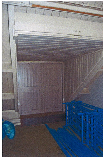
Dakkapel met hijsvoorziening boven de stallenvleugel. Oorspronkelijk was boven de deuren een stalen hijsbalk aangebracht. Deze balken zijn waarschijnlijk bij het vervangen van de boeiboorden door Trespa afgekort.
