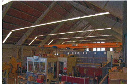
Overzichten van de voormalige rijloods. De kraanbaan, smeerputten, bordessen, galerijen en centraal door de hal lopende gang zijn allemaal later toegevoegd. De oorspronkelijke tribune aan de zuidwestelijke kopgevel is niet meer aanwezig.
