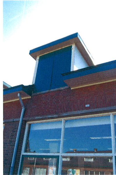
Dakkapel met hijsvoorziening boven de stallenvleugel. Oorspronkelijk was boven de deuren een stalen hijsbalk aangebracht. Deze balken zijn waarschijnlijk bij het vervangen van de boeiboorden door Trespa afgekort.
