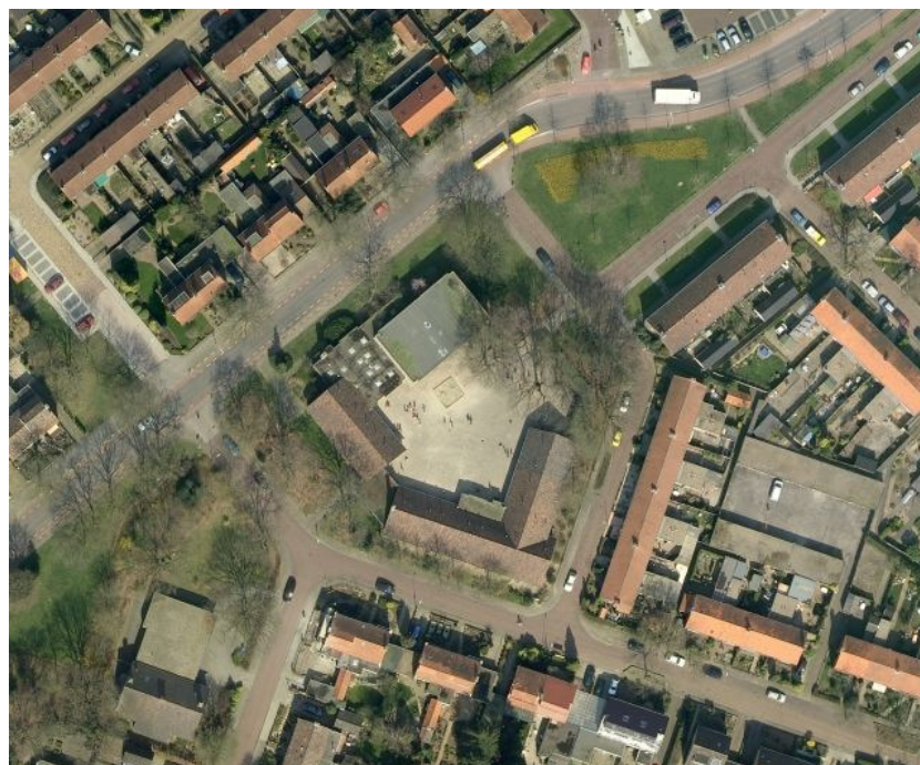
Luchtfoto 2005 geeft de situatie weer van het terrein voordat het schoolgebouw werd gesloopt
