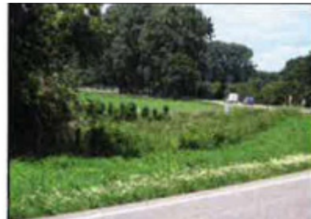
Kapitteldijk annex bouwplaats
