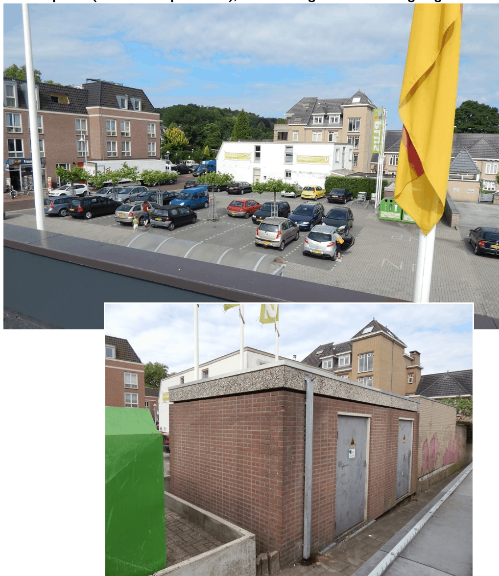
Parkeerplaats (vanaf dak supermarkt), inzet: trafogebouw ZO van garagekelder
