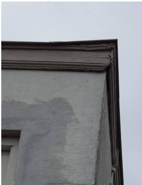
Mogelijkheid voor vleermuizen tussen muur en daklijst van Waterstraat 13
