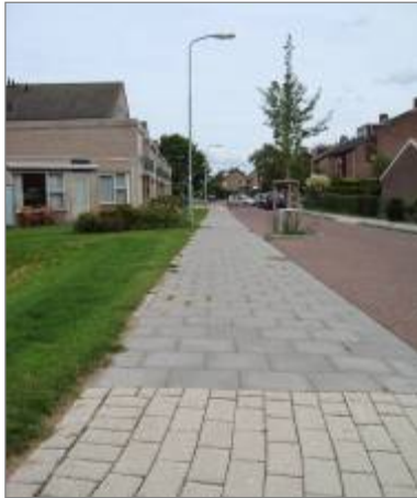
foto 4: Waterstraat, brede trottoirs, geen geleiding
