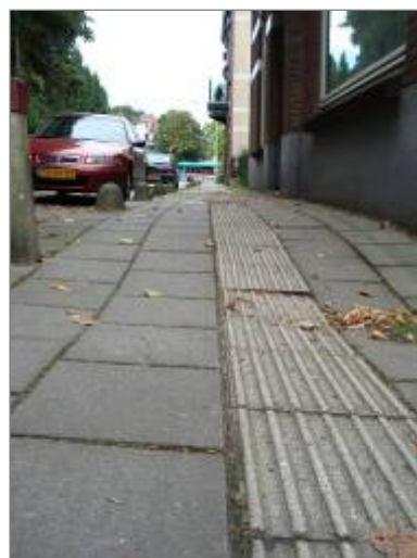
foto 7: Rijkstraatweg, bestrating in gebrekkige staat, veel hoogteverschil
