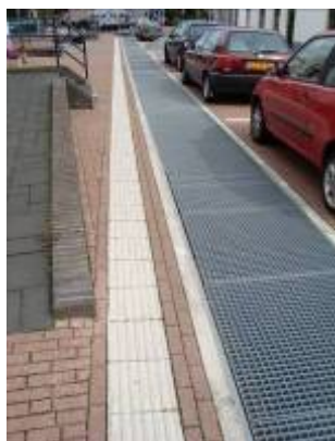
De geleidelijnen zijn te smal en kennen diverse obstakels
