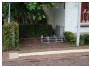
De smalle trottoirs worden snel geblokkeerd, in dit geval zullen geparkeerde fietsen de doorgang blokkeren
