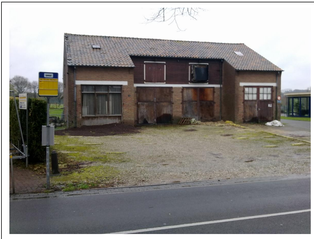
Foto 7. Wylerbaan 1c gezien vanaf de openbare weg.
