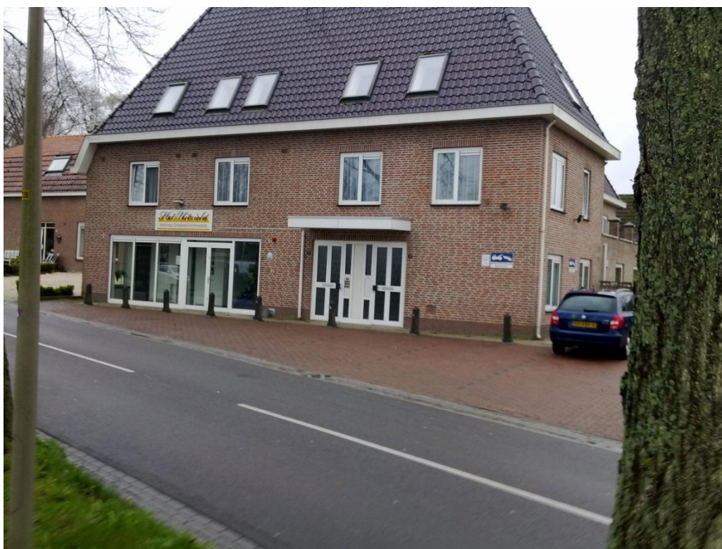
Foto 6. Wylerbaan 1b gezien vanaf de openbare weg.
