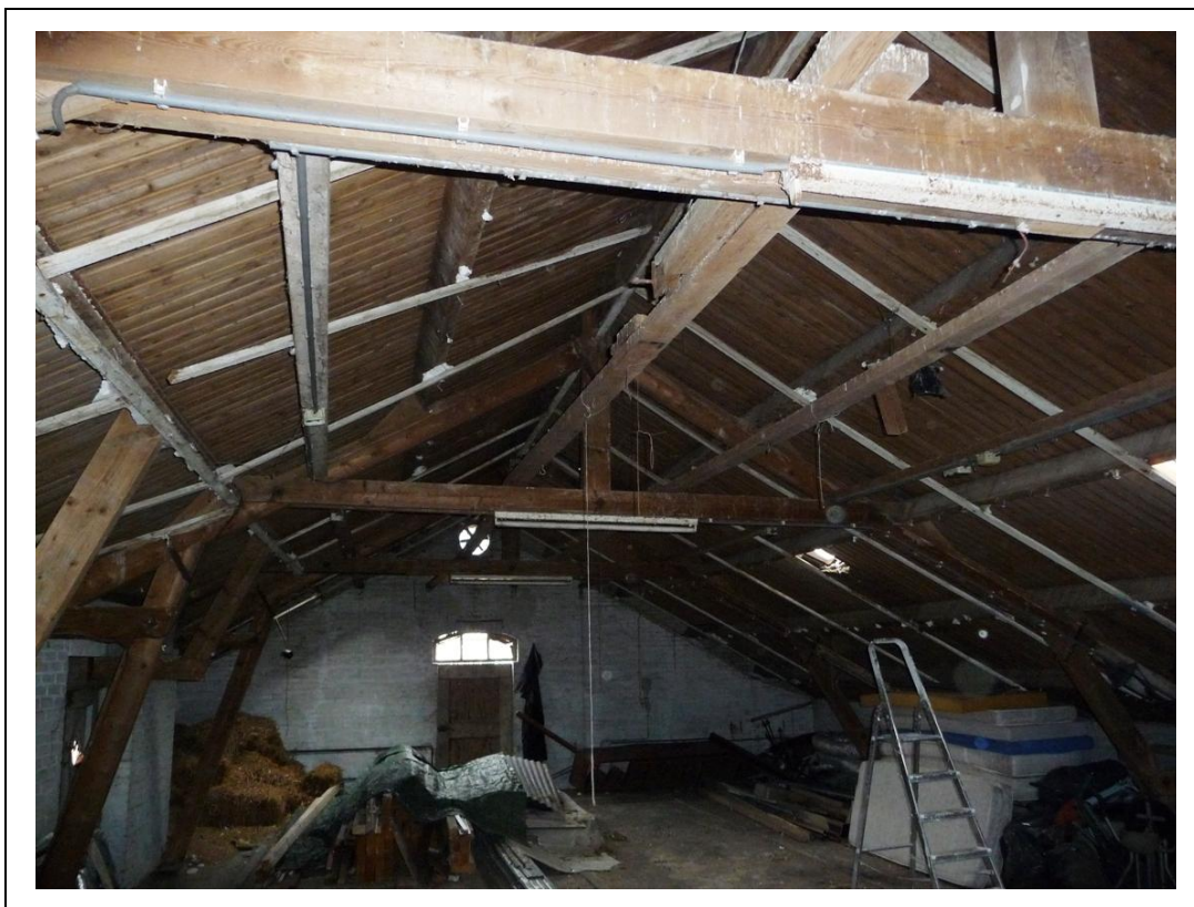
Foto 4. Zolder van Wylerbaan 1c.
