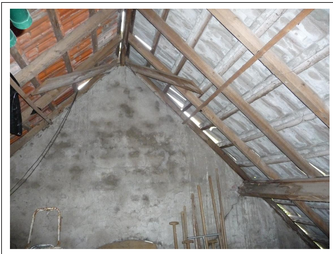
Foto 2. Zolder van schuur Wylerbaan 1b.
