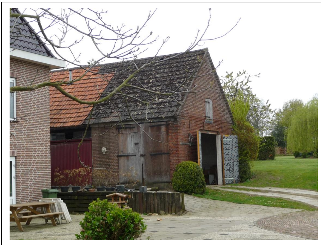
Foto 1. Schuur Wylerbaan 1b
